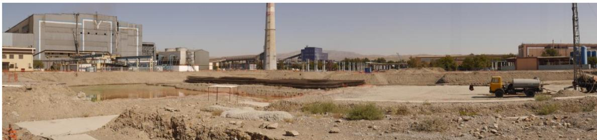
*Рисунок 9.6.1 Общий вид строительной площадки ЛПК, октябрь 2021 г. В левой части фото – накопление грунтовых и ливневых вод в строительной выработке*
